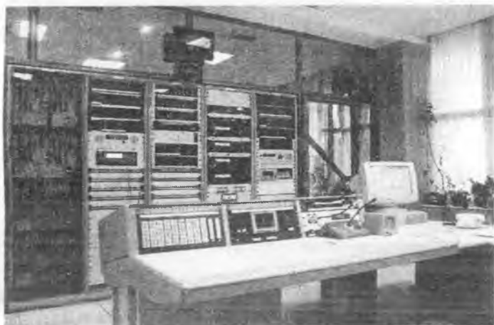
7.18-rasm. Markaziy apparatxona va kross uskunalari.
