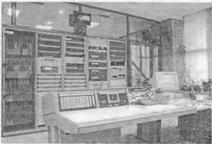
7.18 – rasm. Markaziy apparatxona va kross uskunalari
