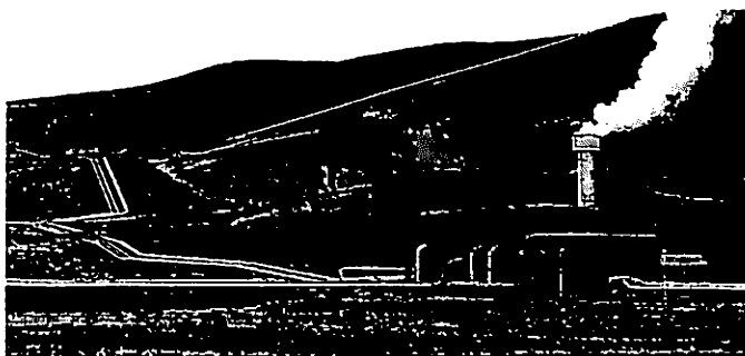
7.8-rasm. Islandiyadagi geotermik elektr stansiya.
