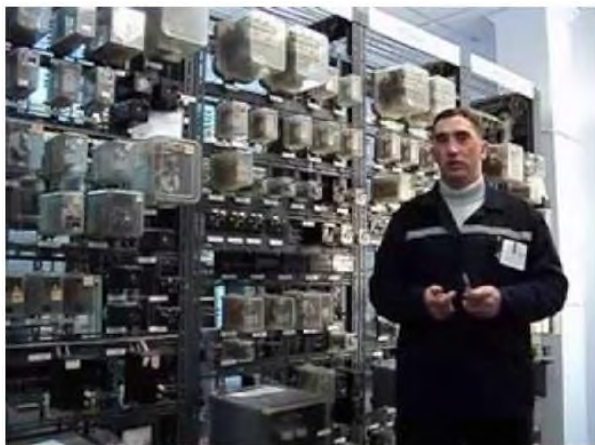
8.12-расм. Трансформаторларни комплекс ҳимоясини электромеханик релелар орқали ҳимоялаш стенди (а) ва замонавий микропроцессорли қурилмалар орқали ҳимоялаш стенди (б)
