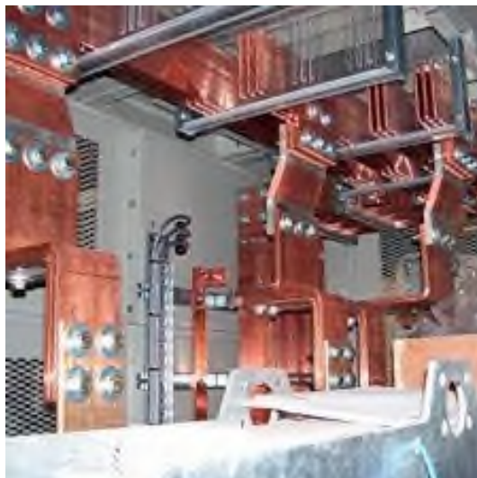
12.3-расм. 6-10 кВли йиғма шиналарни умумий кўриниши.
