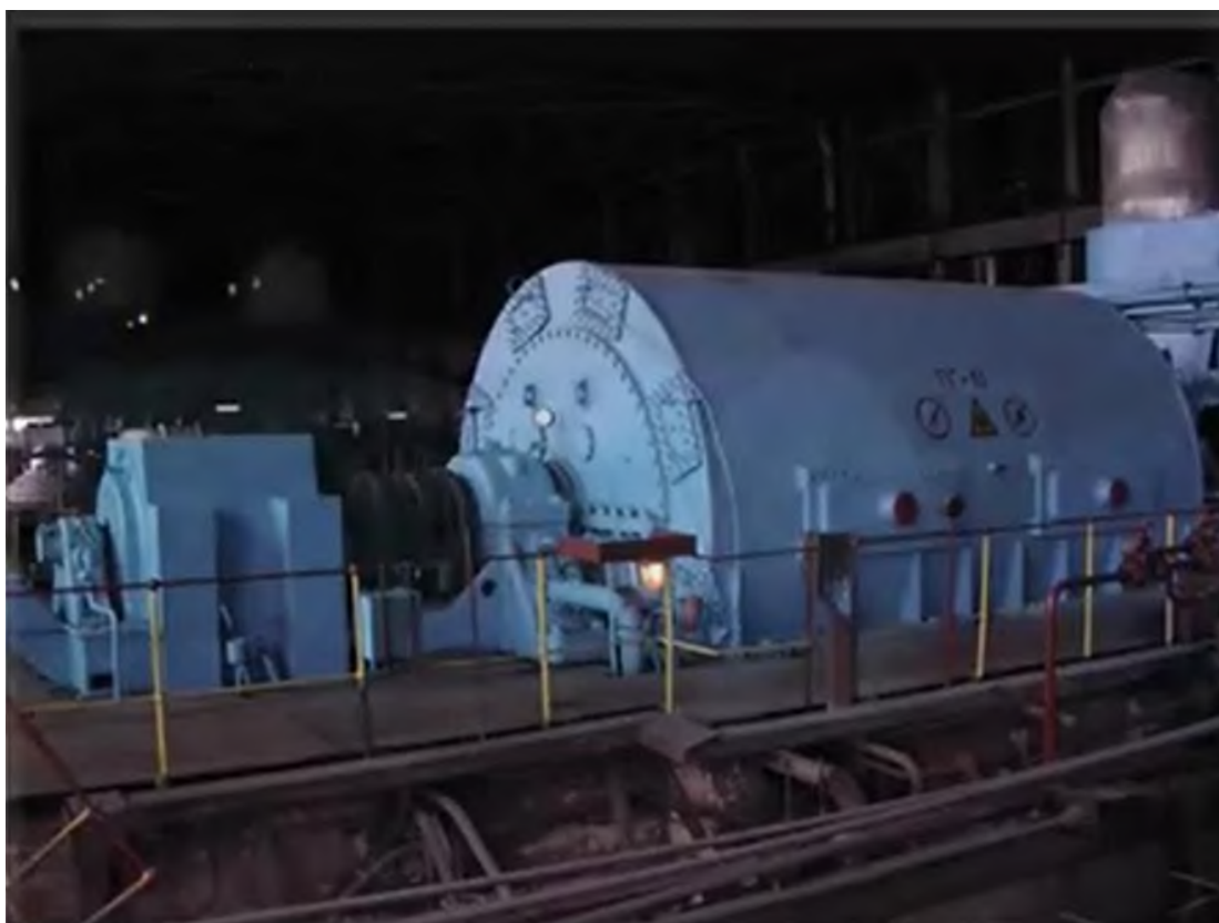
7.1-расм. Катта қувватли синхрон генератор кўриниши.
