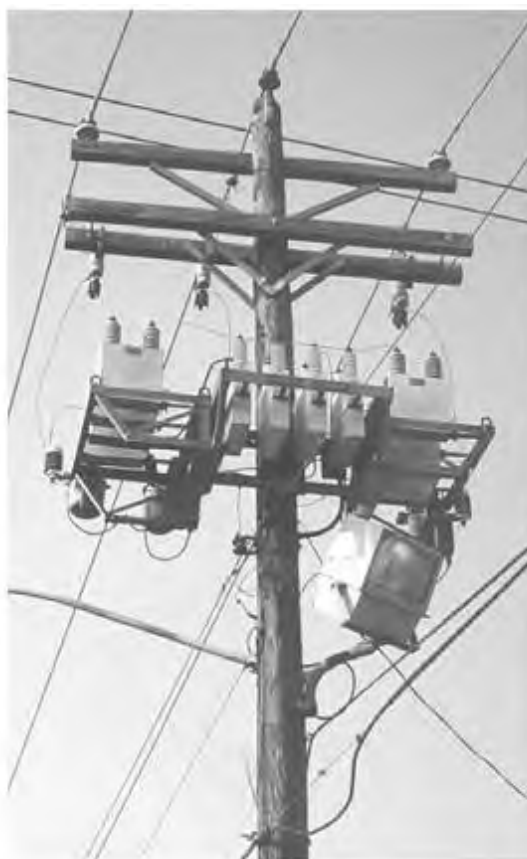
5.5-расм. Масофавий ҳимояни ўрнатиш турларидан бирининг кўриниши
