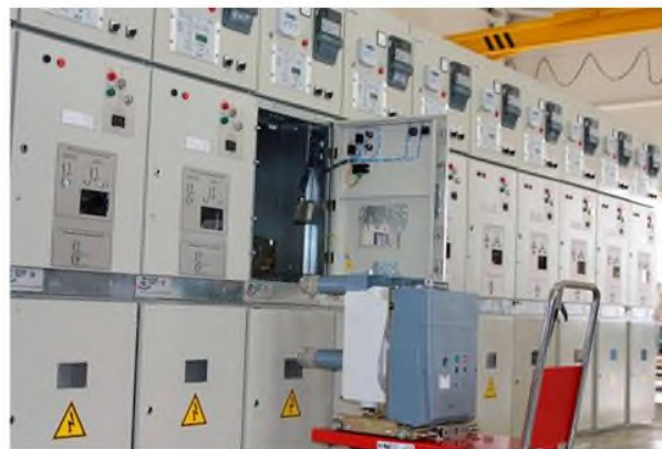
8.12-расм. Трансформаторларни комплекс ҳимоясини электромеханик релелар орқали ҳимоялаш стенди (а) ва замонавий микропроцессорли қурилмалар орқали ҳимоялаш стенди (б)
