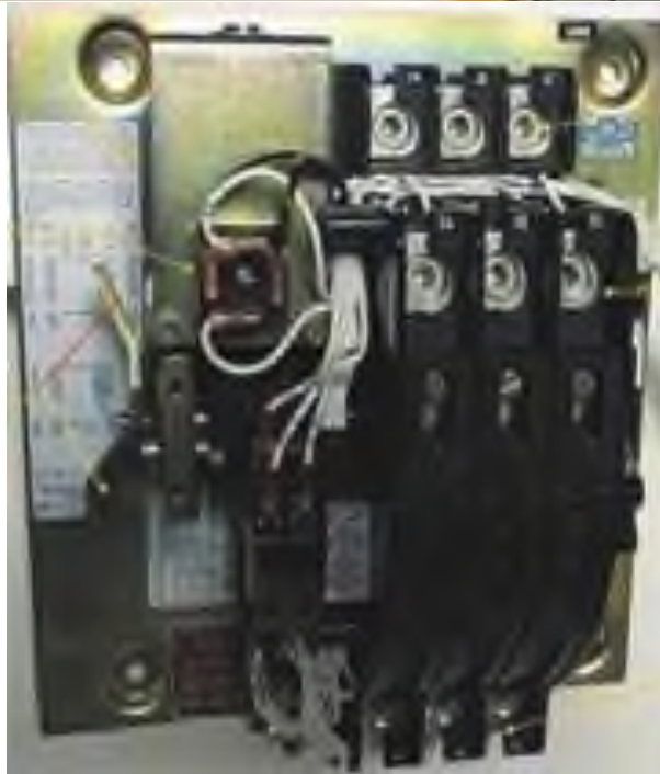
6.2-расм. АҚУ шкафининг умумий кўриниши (а) ва АҚУ (б) қурилмаси.
