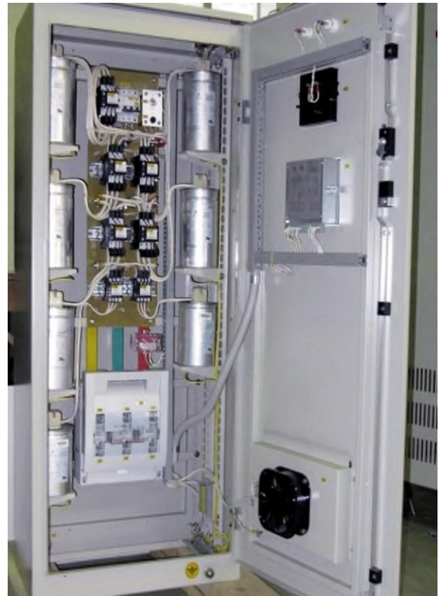
10.2-расм. Якка тартибда жойлашган конденсатор батареяси шкафи (а) ва уни ичкари томонидан кўриниши (б).
