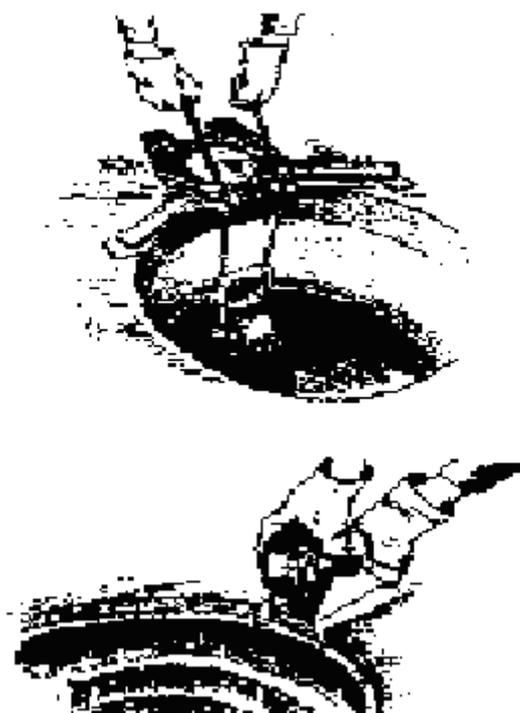
4.13-расм. Кабелни телефон кабел канализация қудуғида тортиб олишда роликлардан фойдаланилади.
