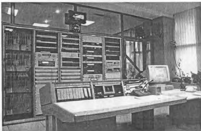
7.47-rasm. Markaziy apparatxona va kross uskunalari.
