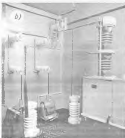
132-rasm. Seksiyalash va parallel ulash postlari: a – PSK-27,5-1 qurilmasining tashqi ko‘rinishi; b – yuqori kuchlanishli bo‘limi; d – parallel ulash postlari PSK-27,5-2 qurilmasining yuqori kuchlanishli bo‘limi.
