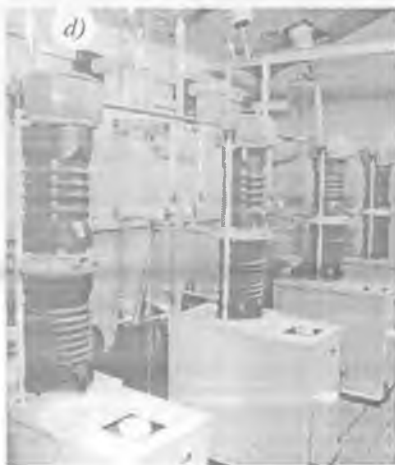
132-rasm. Seksiyalash va parallel ulash postlari: a – PSK-27,5-1 qurilmasining tashqi ko‘rinishi; b – yuqori kuchlanishli bo‘limi; d – parallel ulash postlari PSK-27,5-2 qurilmasining yuqori kuchlanishli bo‘limi.
