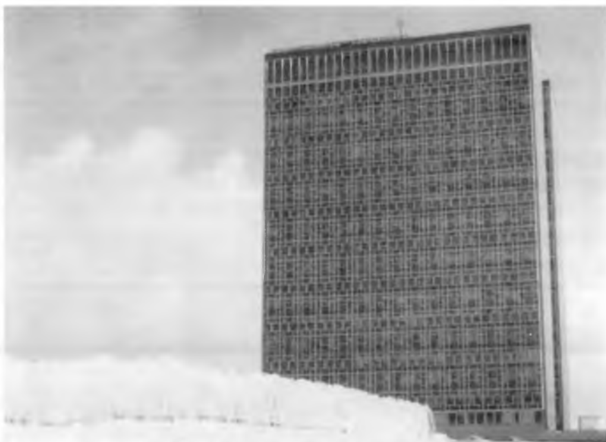
1.5a-rasm. Ma'muriy bino (rekonstruksiyaga qadar).
