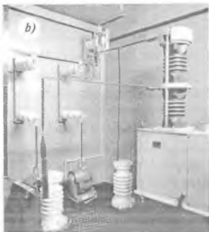
132-rasm. Seksiyalash va parallel ulash postlari: a — PSK-27,5-1 qurilmasining tashqi koʻrinishi; b — yuqori kuchlanishli boʻlimi; d — parallel ulash postlari PSK-27,5-2 qurilmasining yuqori kuchlanishli boʻlimi.
