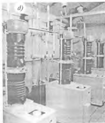
132-rasm. Seksiyalash va parallel ulash postlari: a — PSK-27,5-1 qurilmasining tashqi koʻrinishi; b — yuqori kuchlanishli boʻlimi; d — parallel ulash postlari PSK-27,5-2 qurilmasining yuqori kuchlanishli boʻlimi.
