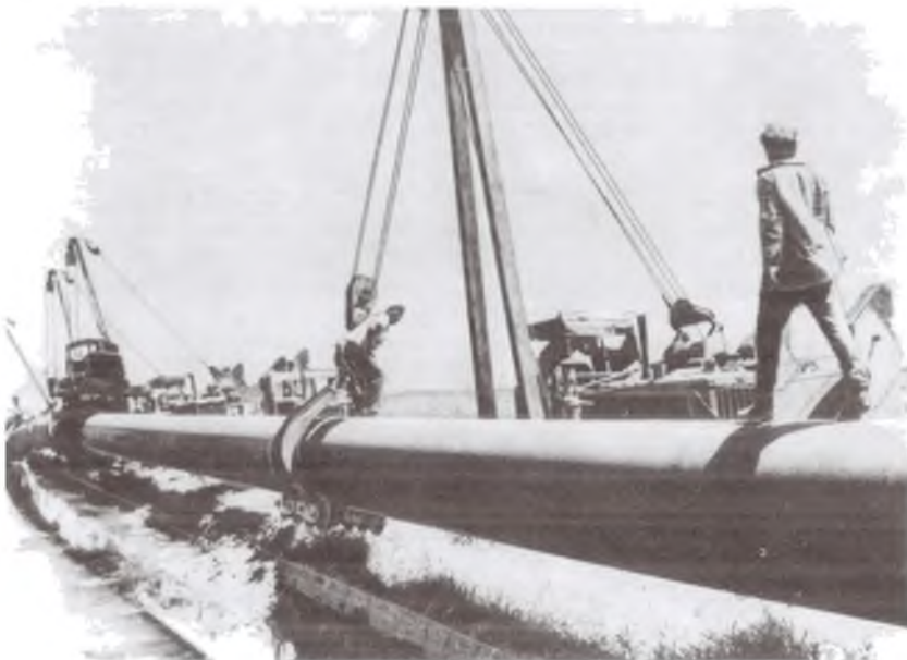
Бухоро-Урал газопроводи қурилиши. 1980 йил.
