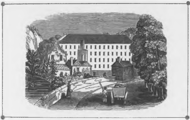
Ташкилий ўзгаришлар, инклюзив институтларнинг маҳсули: Кромфорддаги Ричард Аркрайт фабрикаси. Гренжер коллекцияси, Нью-Йорк.
